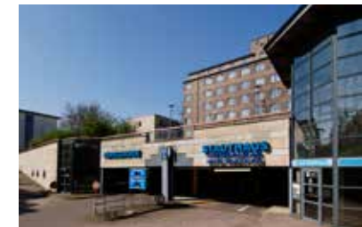
Oben: Stadt Hamburg – Parkleitsystem; Mitte: Stadtwerke Münster – Elektrotankstelle; Unten: Stadt Osnabrück – Stadthaus-Garage
