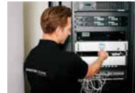
Links: Messungen zur Fehlersuche im Verteilerschrank
