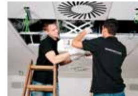
Links: Vorbereitende Arbeiten für den Anschluss in der Verteilung
